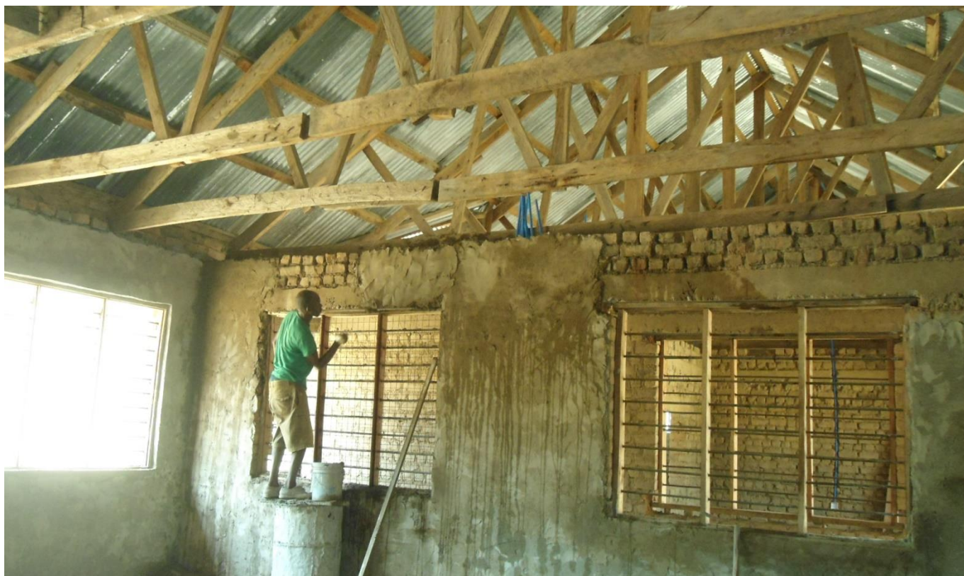
La scala improvvisata con il bidone vuoto della nafta .... Si intravedono anche i cavi per l'impianto elettrico posati sotto malta. Le travature sono l'impalcato che sostiene il tetto. Presto saranno realizzati i soffitti e le travi non saranno più in vista
